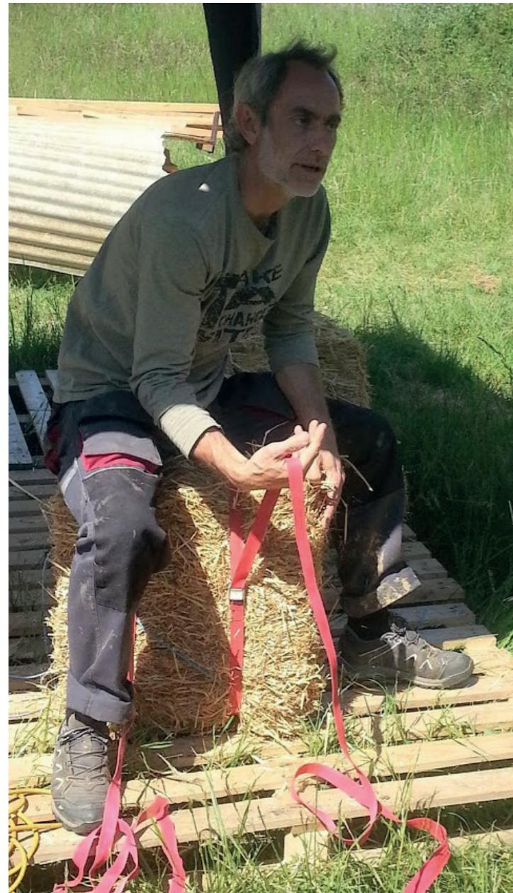
Les sangles de type « bagagiste », pour sur-comprimer les bottes de paille. Très utiles pour finir de remplir un mur entre l'avant-dernière botte et la lisse haute. Elles permettent de réduire la longueur de la botte le temps de la pose, puis de lui rendre sa forme initiale de façon à avoir un contact parfait entre l'isolant et la structure et ce, rapidement et sans forcer.
